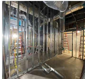
ITI – Restroom/Shower Framing
