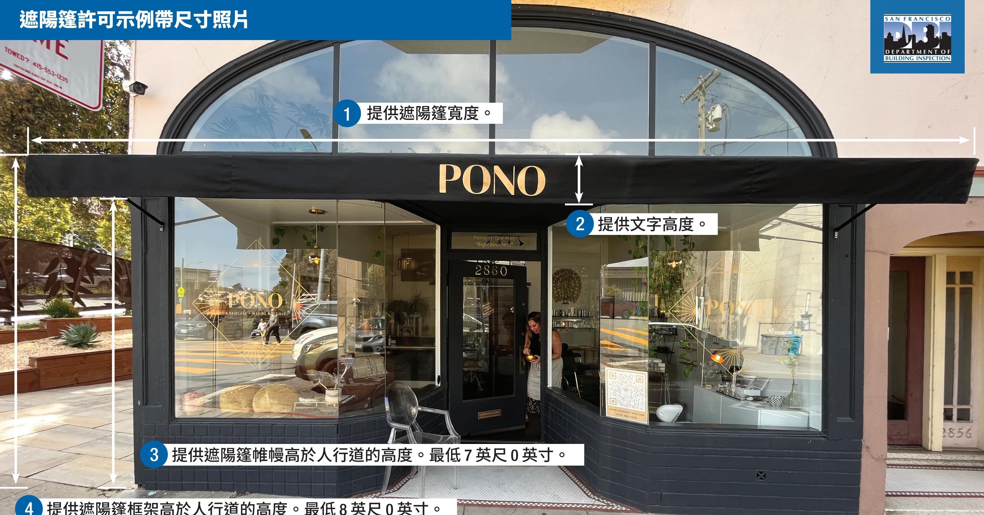
4 提供遮陽篷框架高於人行道的高度。最低 8 英尺 0 英寸。
